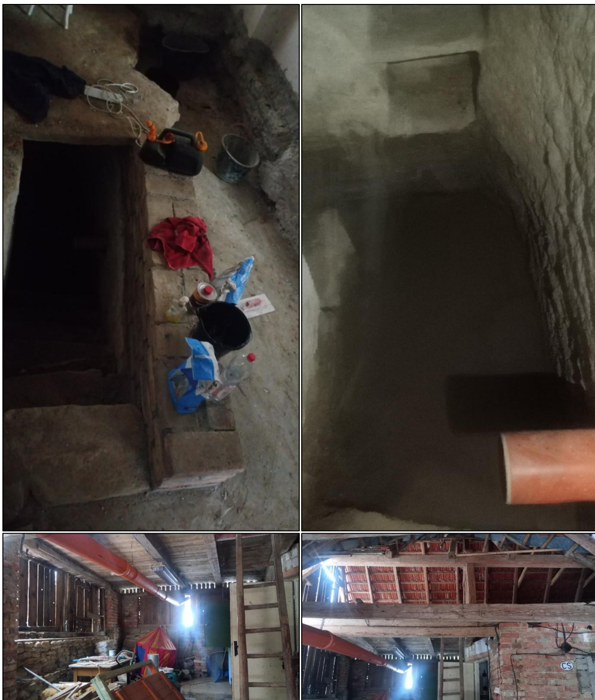
RD Osiky, č.p. 39 – sklep a hospodářský přístavek
