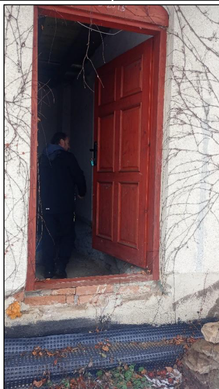
RD Osiky, č.p. 39 – exteriér
